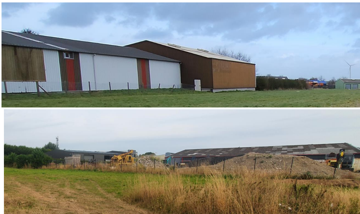
PHOTO 4 : VUES DES ACTIVITES ET BATIMENTS INDUSTRIELS AU NORD DU PROJET
